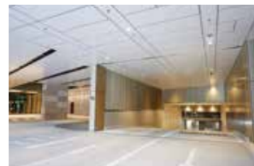
日比谷通り側駐車場出入口
